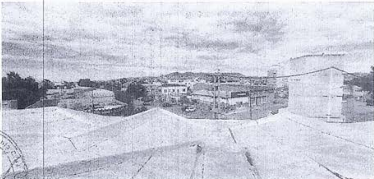
CUBIERTA ABOVEDADA DEL GIMNASIO – VISTA EXTERIOR
