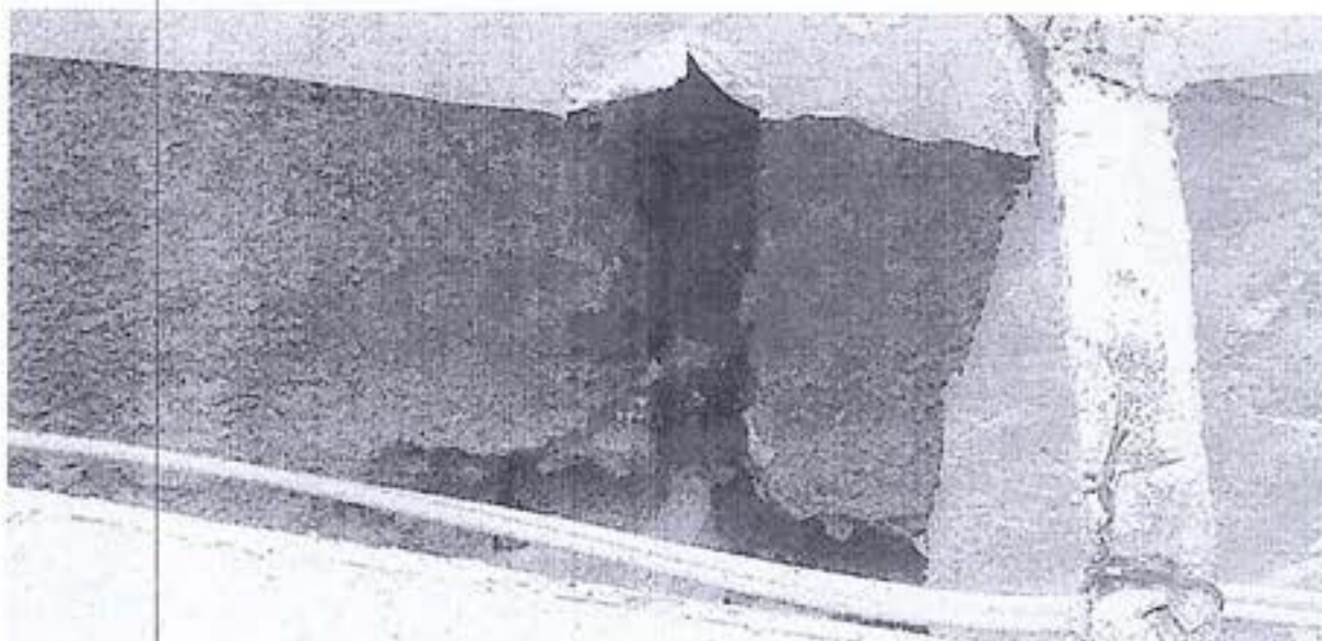
CON UN ACERCAMIENTO. ZOOM FOTOGRÁFICO. PODEMOS VER ARMADURA.
